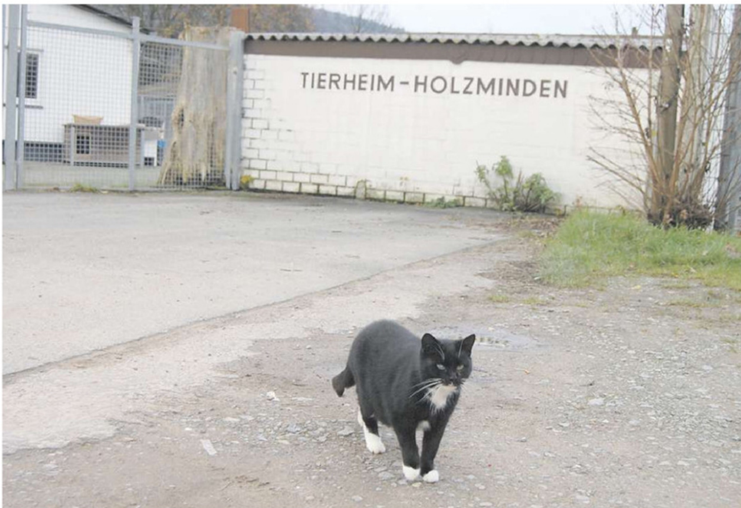
Eine Sanierung ist dringend notwendig: Das Tierheim Holzminden soll repräsentativer und baulich aufgewertet werden.
